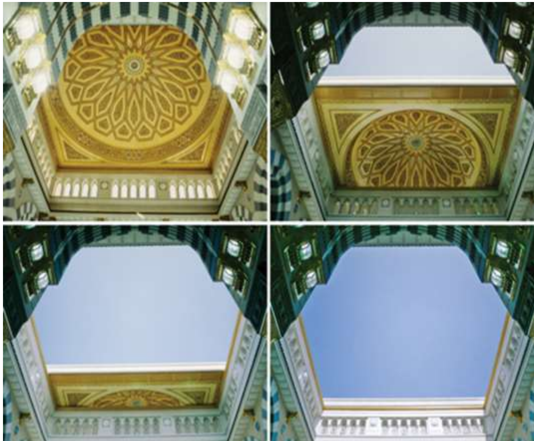
الشكل رقم (29) صورة للقباب المتحركة أثناء عملية الفتح، والتي تحدث خلال اليوم للقيام بعملية تجديد الهواء داخل الحيزات الداخلية للحرم النبوي، والتي تمثل طفرة في مجال العمارة وحلولاً للحيزات الداخلية في العمارة المصدر: تصوير الباحثة بتاريخ 2018/08/28.
